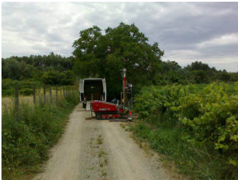
Strumentazione su postazione CPT4
