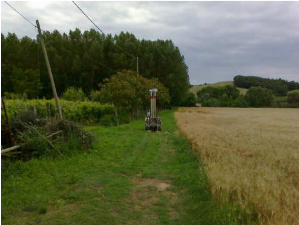
Strumentazione su postazione CPT6
