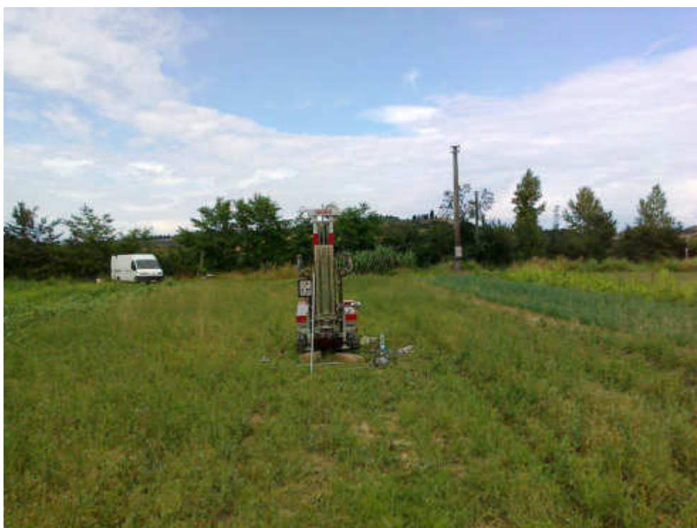
Strumentazione su postazione CPT5
