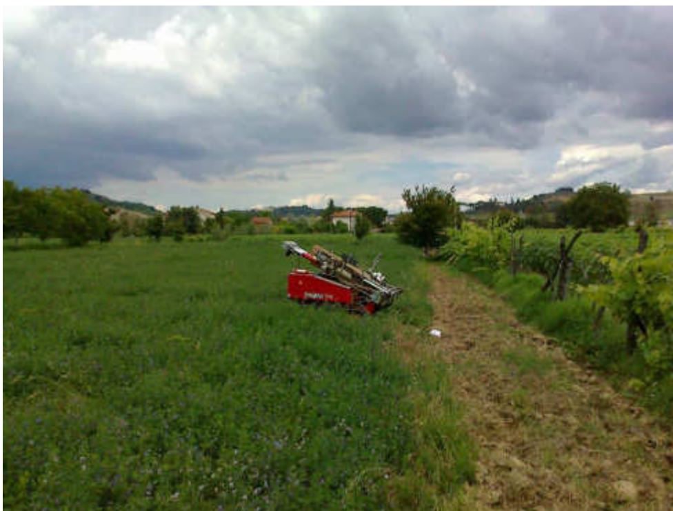
Strumentazione su postazione CPT3
