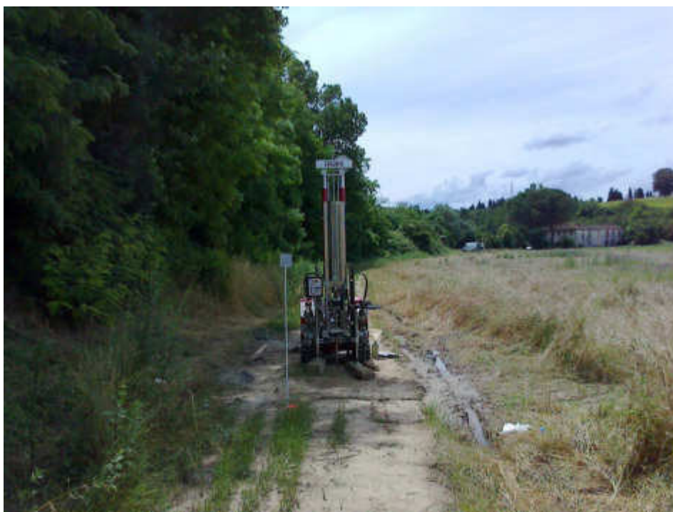
Strumentazione su postazione CPT2
