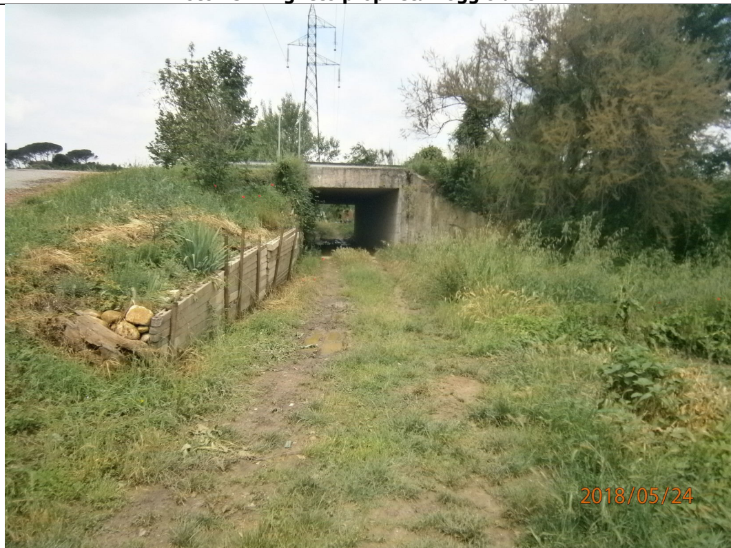
Foto 16 – Sottopasso in prossimità della SP4 Volterrana
