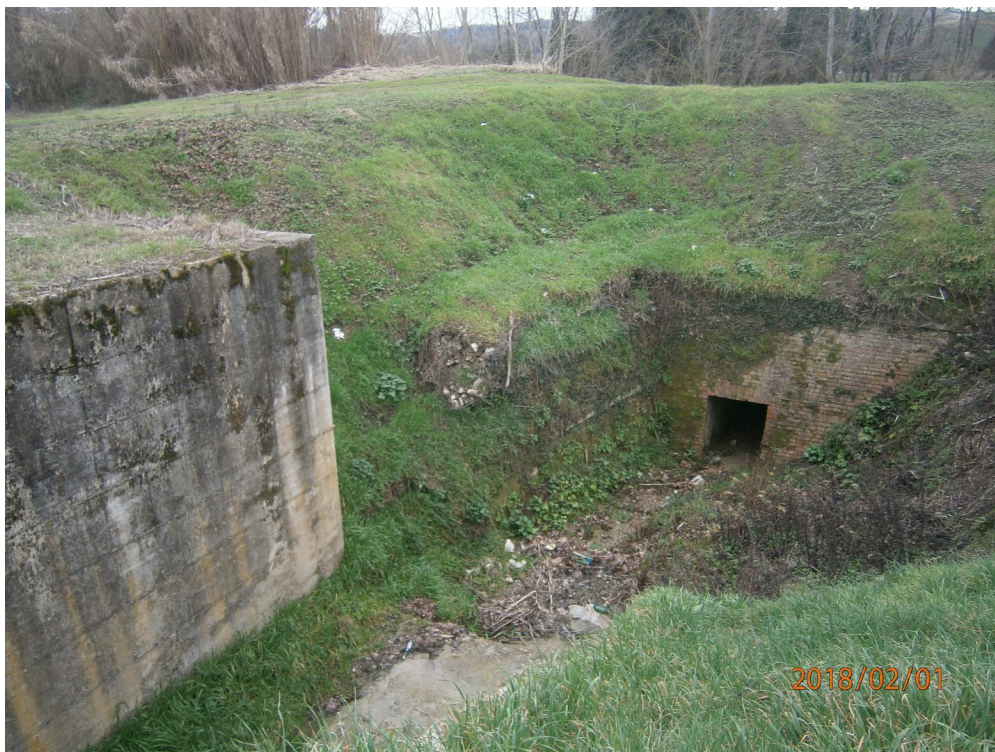
Foto 9 – Scarico del sottopasso idraulico verso il fiume Elsa
