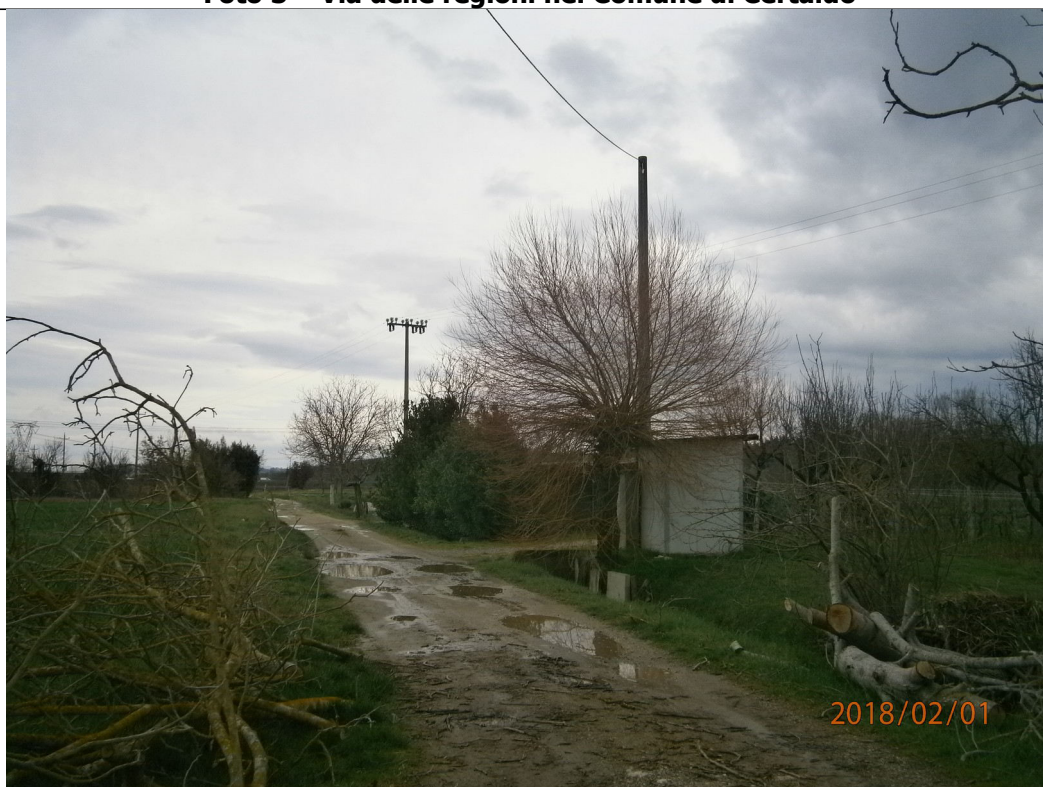
Foto 4 – Strada vicinale dei Confini e linea aerea E-Distribuzione
