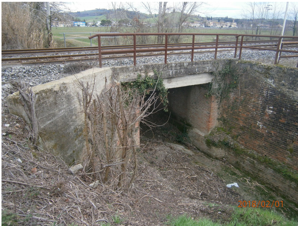
Foto 8 – Linea ferroviaria e sottopasso idraulico
