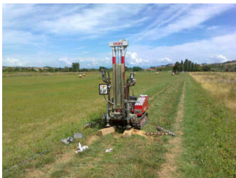
Strumentazione su postazione CPT1
