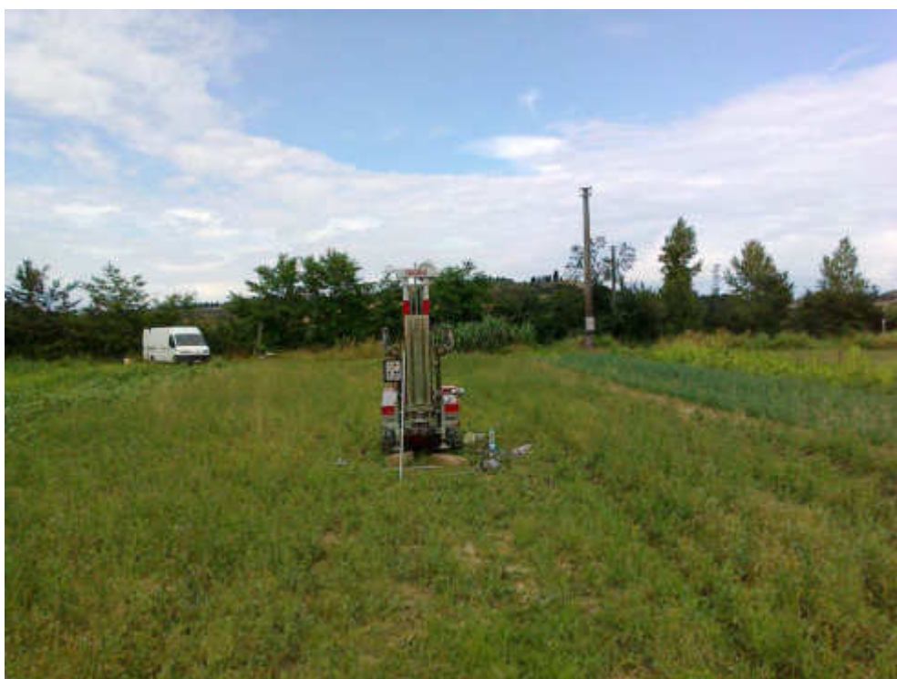
Strumentazione su postazione CPT5
