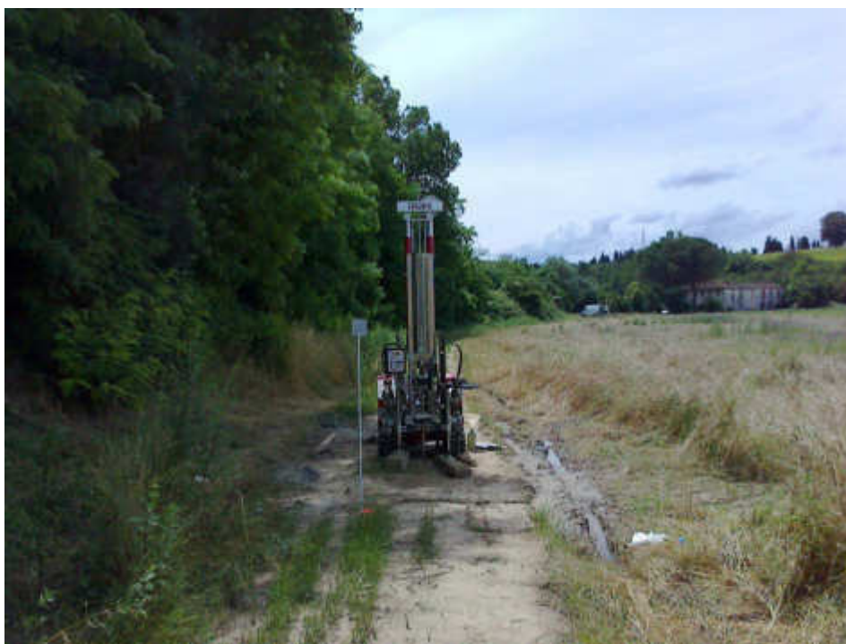
Strumentazione su postazione CPT2
