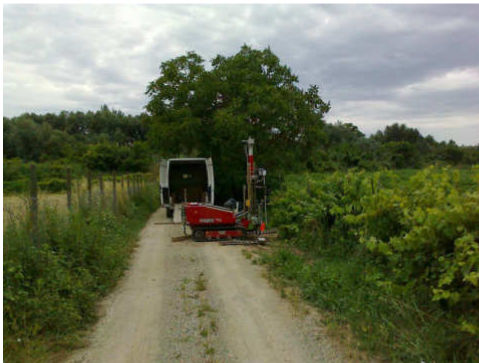
Strumentazione su postazione CPT4
