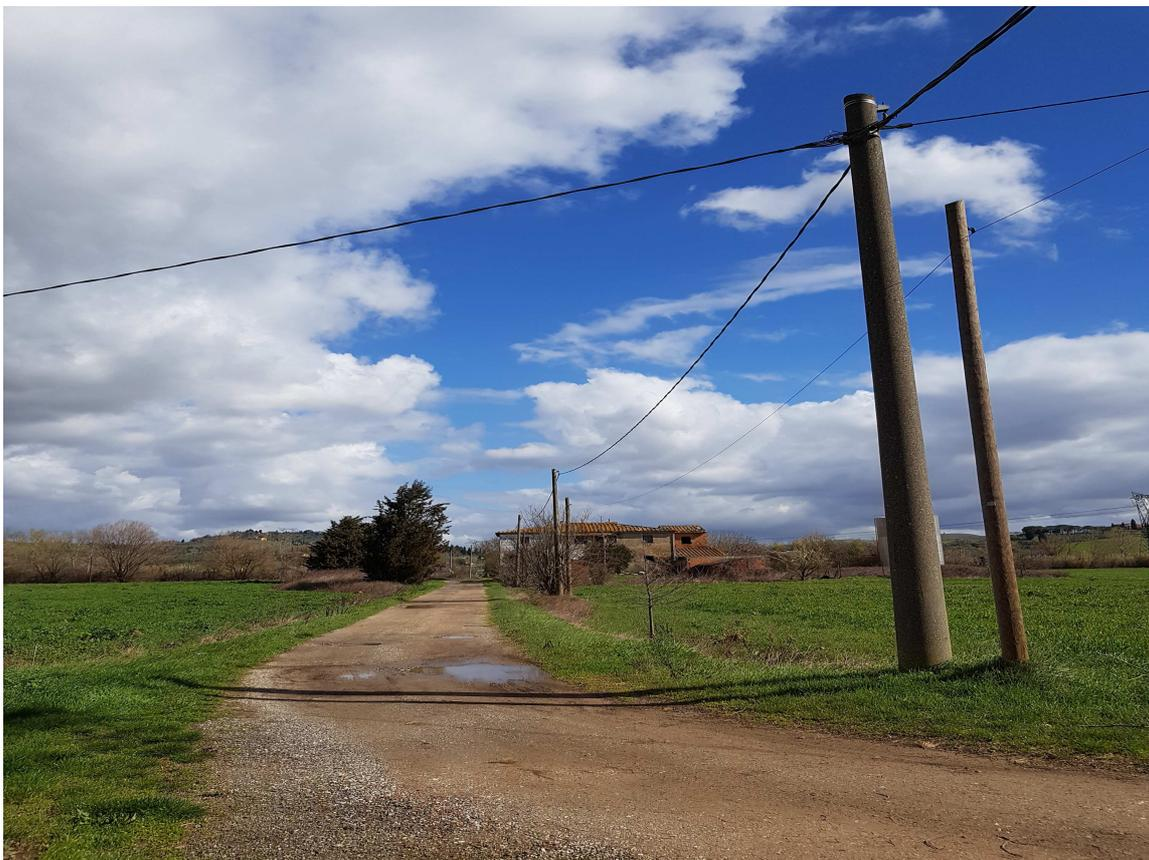
Sempre in corrispondenza della sezione 19 progressiva 550, in prossimità della Strada Vicinale dei Confini, è presente una linea aerea di proprietà ENEL in cavo BT 380 V, che si sviluppa parallelamente alla linea aerea TIM (interferenza 2A).
