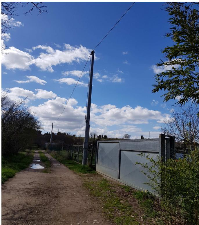
in corrispondenza della sezione 106 progressiva 2+540, in prossimità di una traversa di via Pettinamiglio, è presente una linea aerea di proprietà ENEL in cavo BT 380 V, che alimenta una serie di poderi agricoli recintati.
