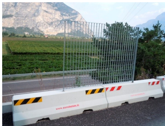
Sulla sinistra, esempio di recinzione modulare di rete elettrosaldada; sulla destra, esempio di barriera New Jersey con recinzione tipo orso grill
